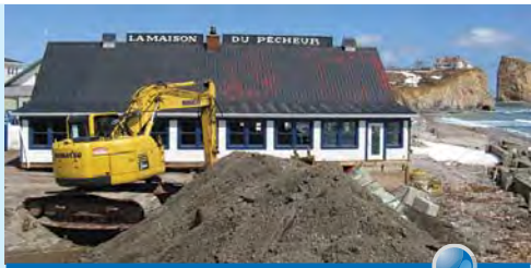
La Maison du Pêcheur is being prepped for relocation
